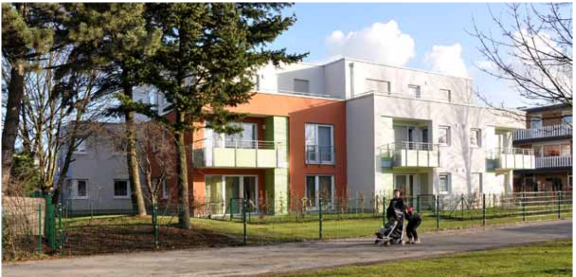
Seniorenwohnanlage Matthäushof, Grevenbroich, Bauverein Grevenbroich – zertifiziert 2009
